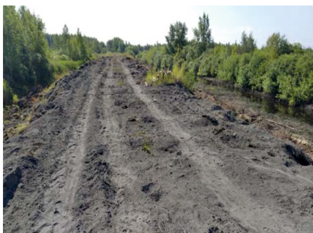
Рис.5. Дамба золоотвала (расчищенная от поросли)
