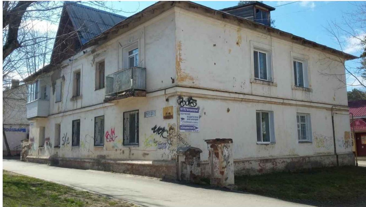
Существующее состояние главного фасада в осях 4-1 и бокового фасада в осях Б-А
