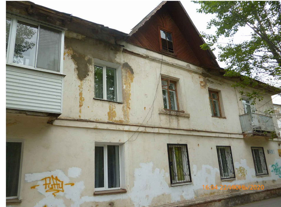
Существующее состояние главного фасада в осях 4-1 (фрагмент)
