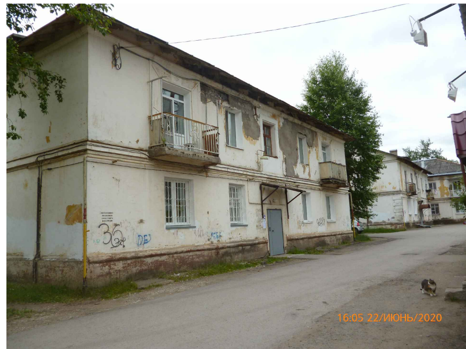
Существующее состояние дворового фасада в осях 1-4
