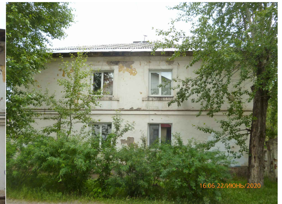
Существующее состояние бокового фасада в осях А-Б
