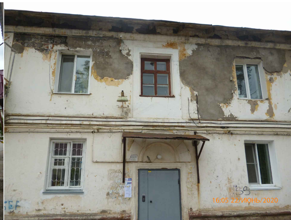
Существующее состояние дворового фасада в осях 1-4 (фрагмент)
