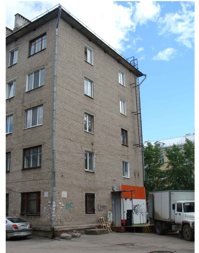
Существующее состояние торцевого фасада в осях Б-А
