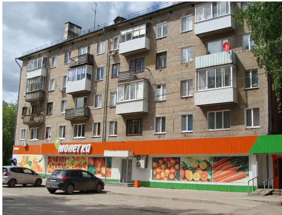
Существующее состояние главного фасада в осях 1-2
