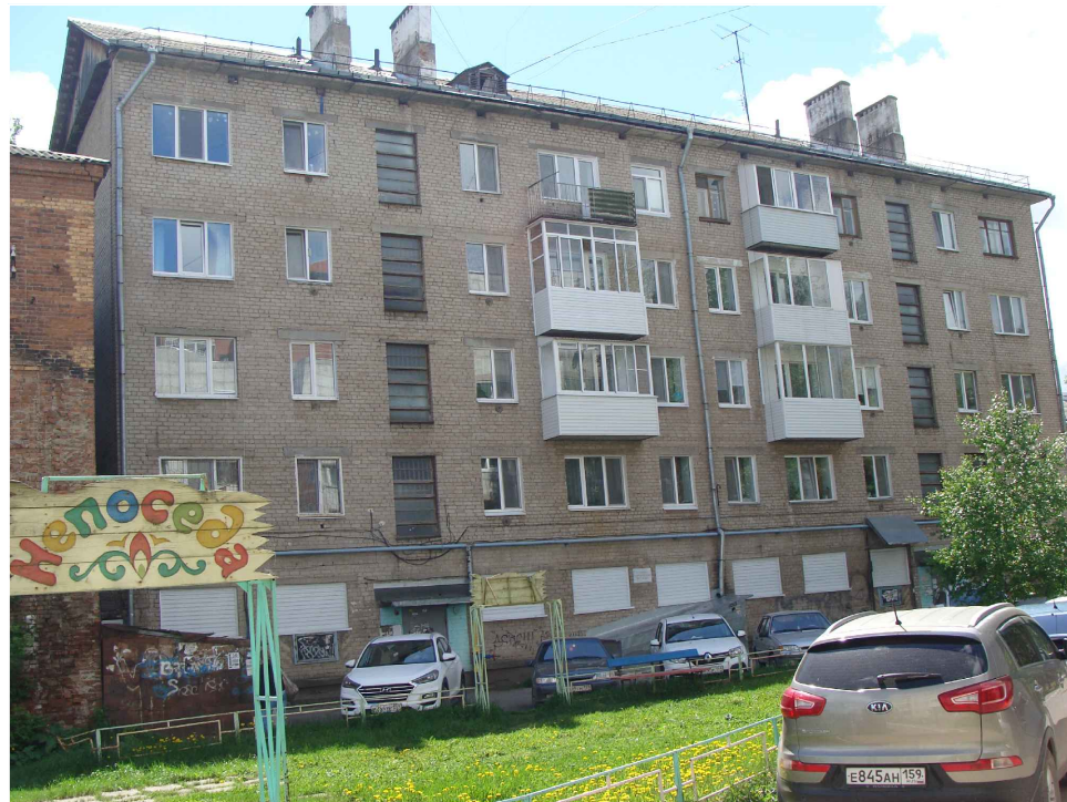
Существующее состояние дворового фасада в осях 2-1
