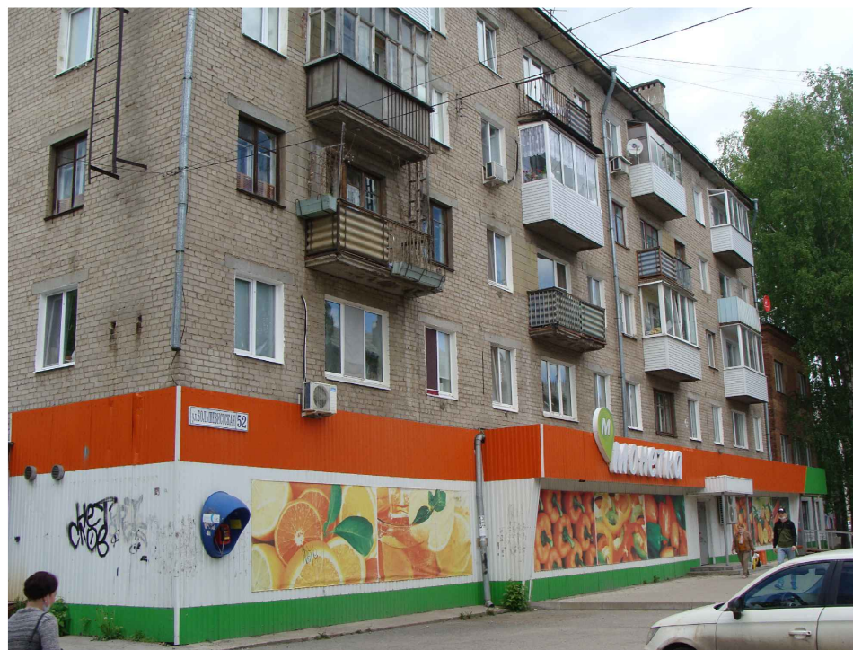
Существующее состояние торцевого фасада в осях А-Б
