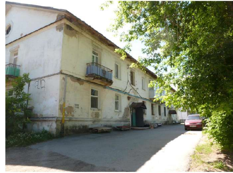
Существующее состояние дворового фасада
