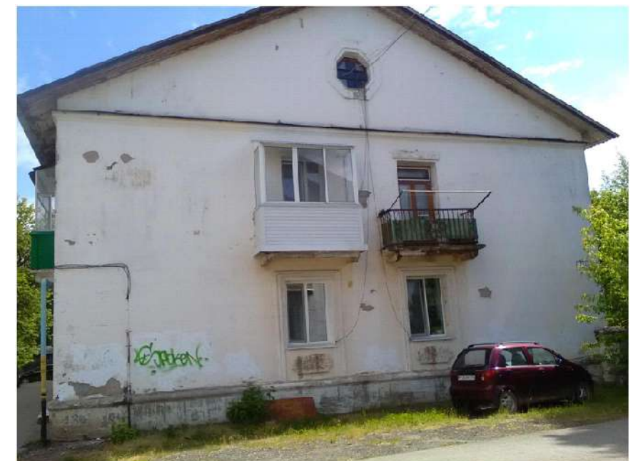
Существующее состояние бокового фасада
