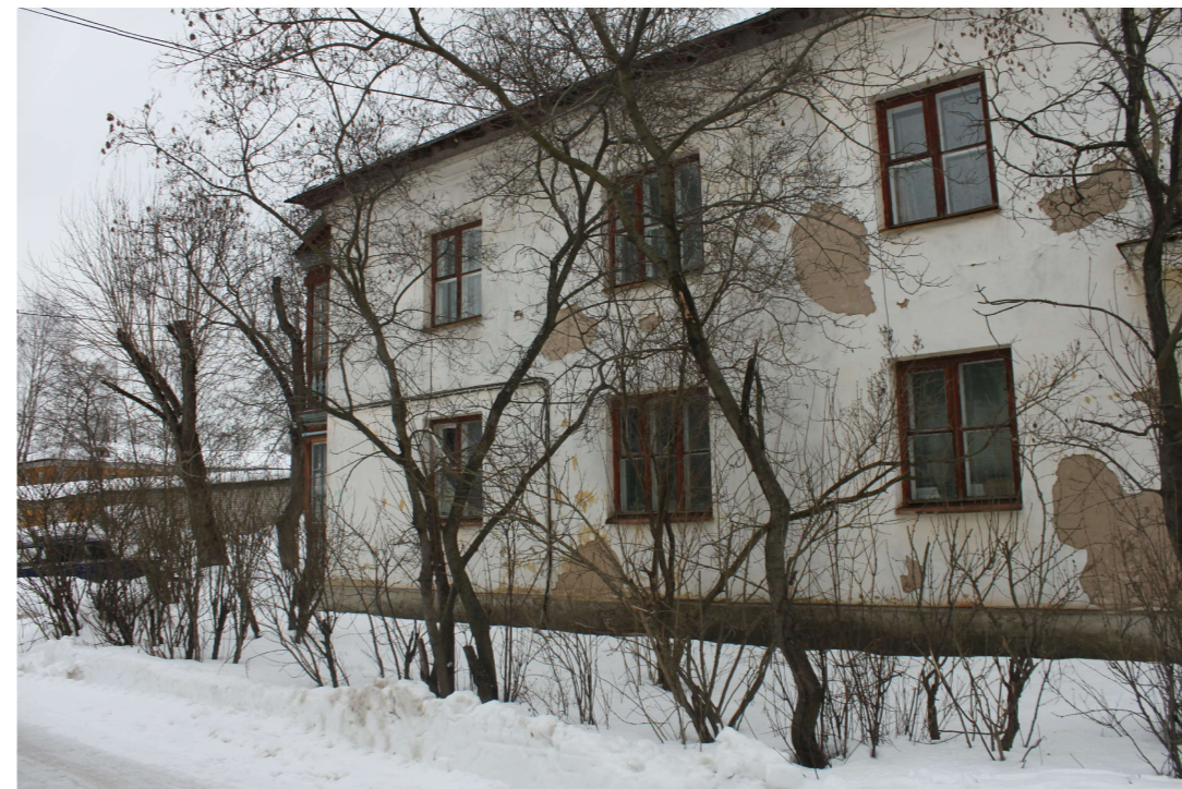
Существующее состояние бокового фасада
