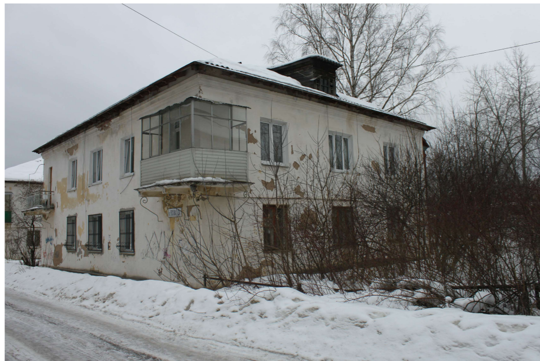
Существующее состояние главного фасада
