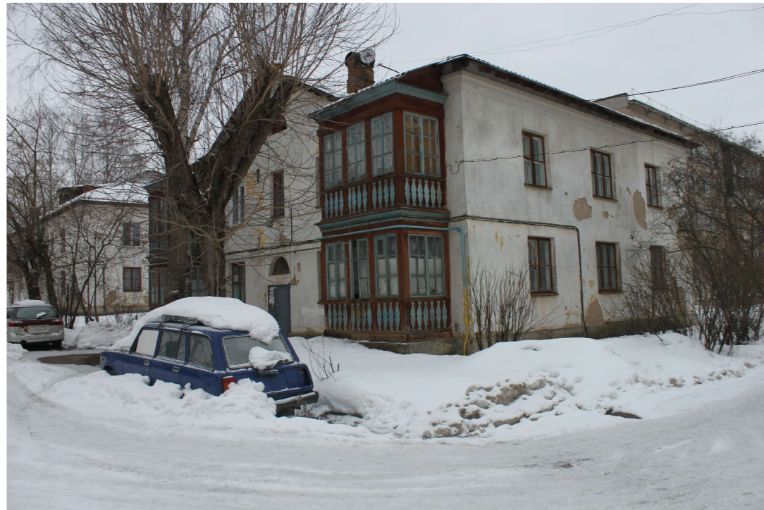
Существующее состояние дворового и бокового фасадов
