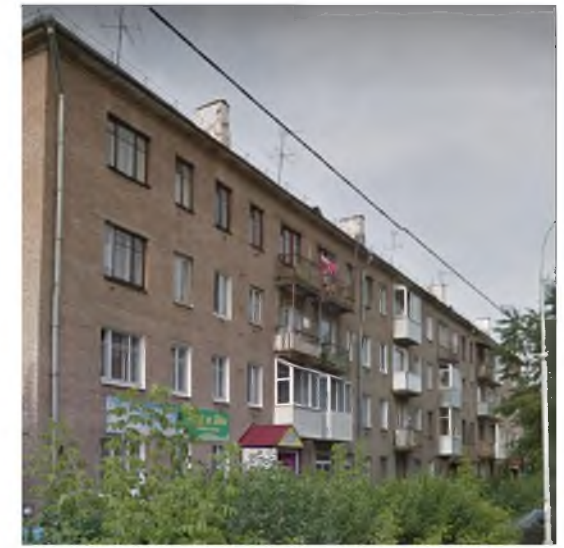
Существующее состояние главного фасада в осях 2-1
