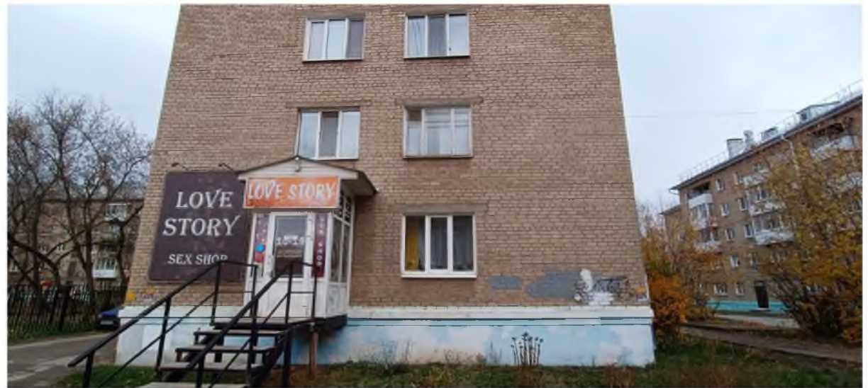
Существующее состояние бокового фасада в осях А-Б
