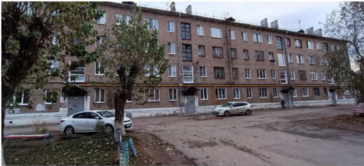
Существующее состояние дворового фасада в осях 1-2
