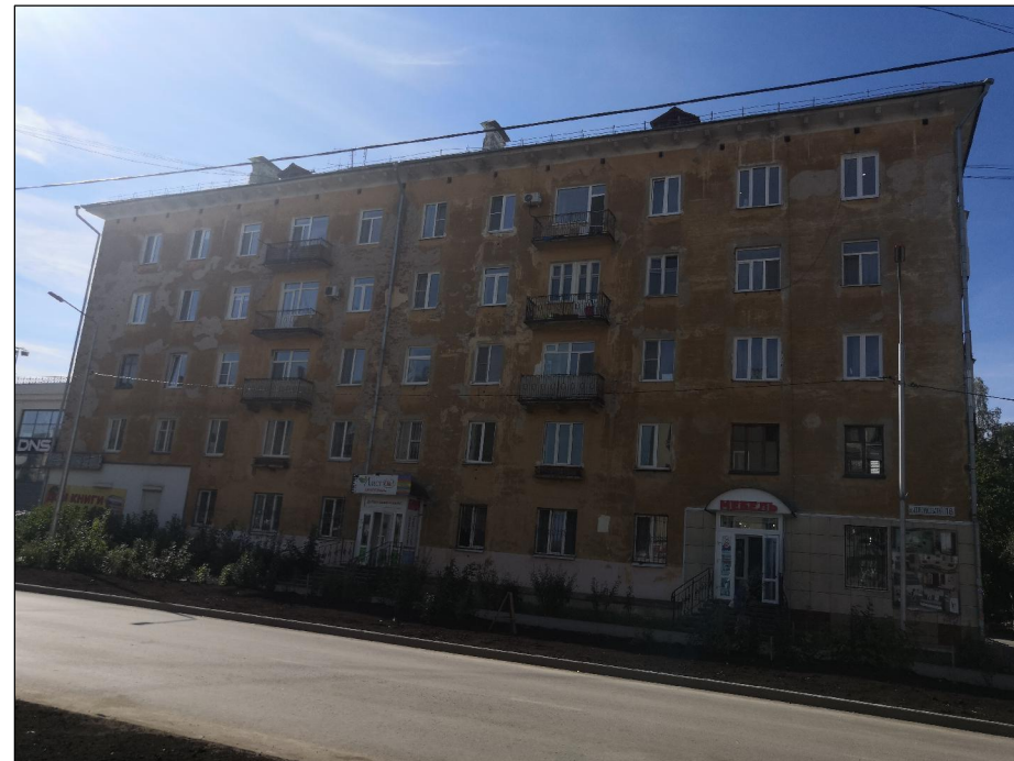
Существующее состояние фасада в осях А-Г
