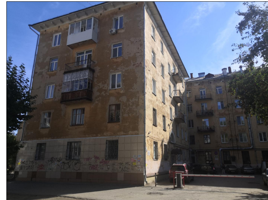
Существующее состояние фасадов в осях Б-3 и Г-Б
