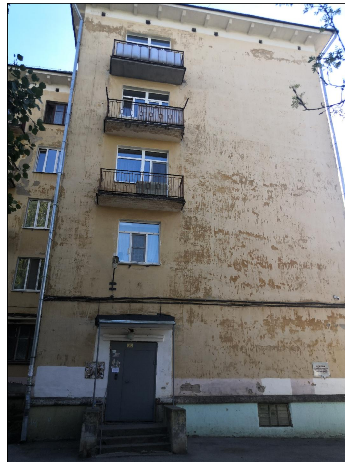
Существующее состояние фасада в осях 2-1
