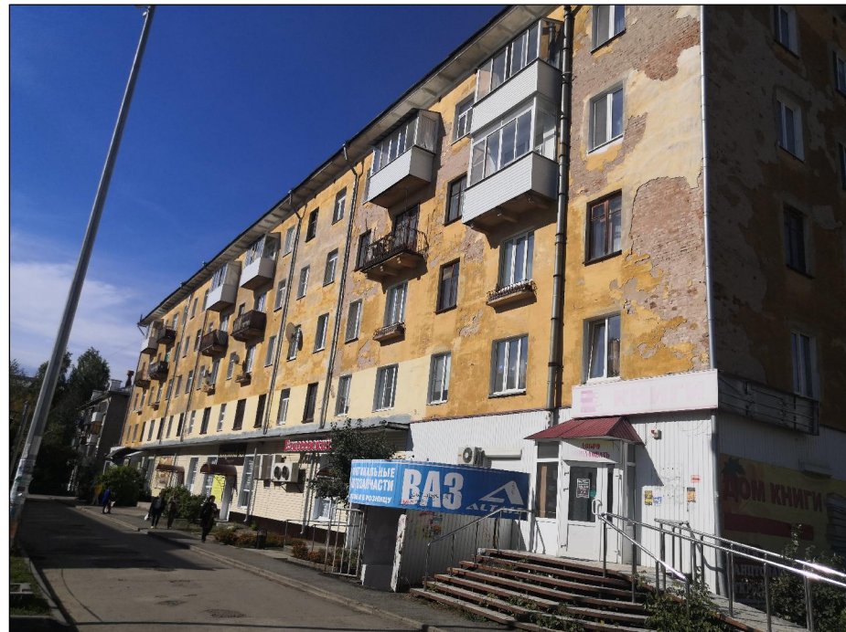
Существующее состояние фасада в осях 1-5
