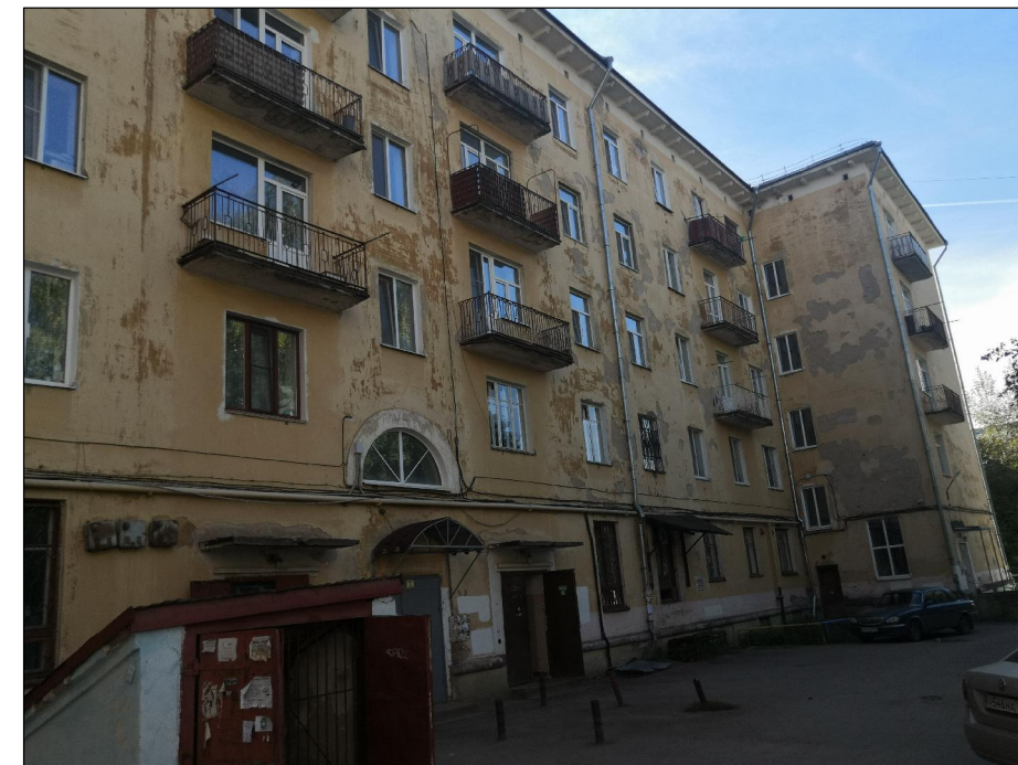
Существующее состояние фасада в осях 4-2
