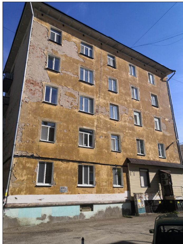
Существующее состояние фасада в осях В-А
