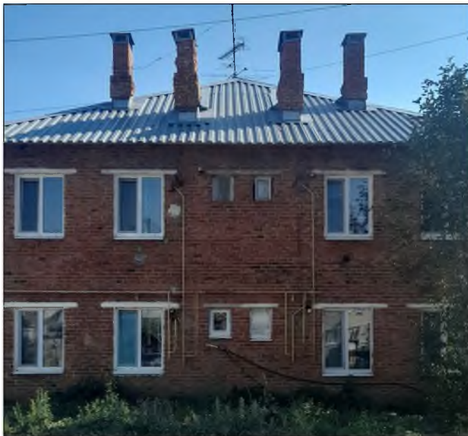
Существующее состояние бокового фасада в осях А-В
