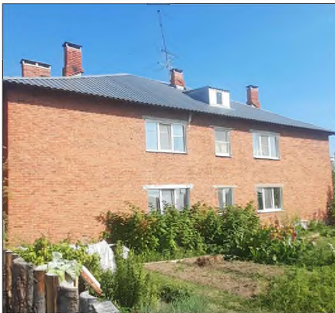
Существующее состояние главного фасада в осях 2-1
