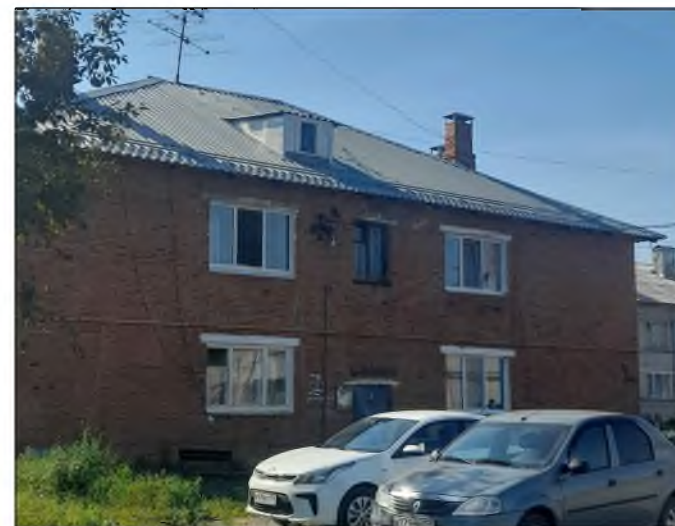
Существующее состояние дворового фасада в осях 1-2
