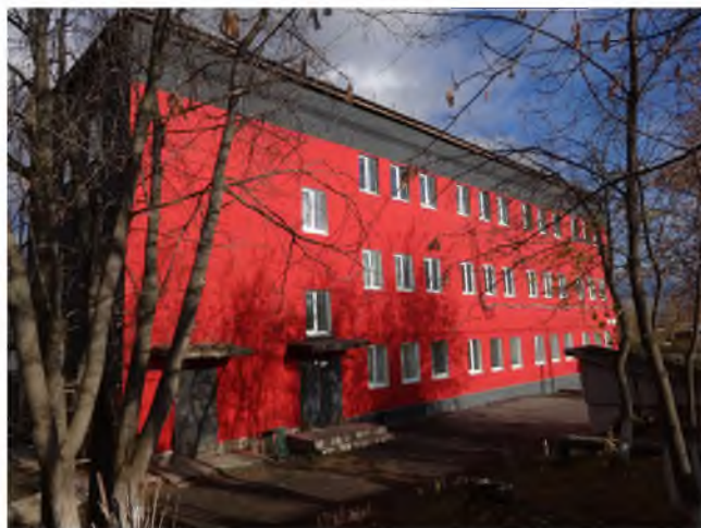
Главный фасад (лит. Д)
